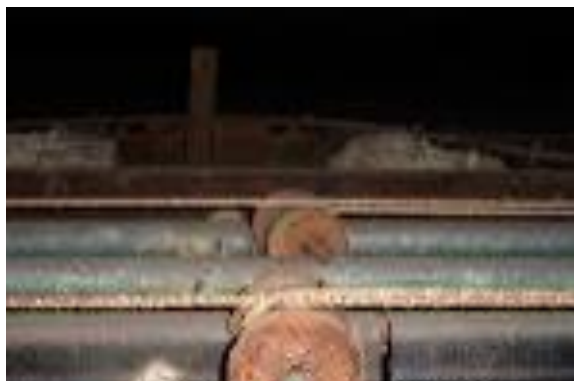
Imagen 10, Imagen 11, Imagen 12. Muestra los CARRIZOS y CUERDAS de TRAMOYA del TEATRO DE BELLAS ARTES desde una altura de 15m sobre el nivel del escenario y denota el deterioro de cada elemento que la hace funcionar. Fuente: archivo propio.
